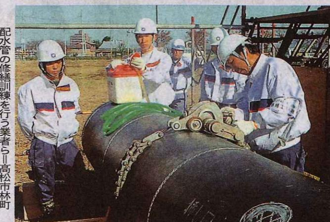
地上に仮設した配水管(直徑九十cm)を駆け付けた業者が修繕した。業者は特殊な工具を使い、損傷部分ごと配水管を覆う漏水修理金具を素早く固定。修繕作業の終了後、職員が漏水が止まるのを確認したとして通水の復旧を指示した。また、実際の修繕作業中は断水となるのを踏まえ、給水車も配備。万一の際、市民に不安を与えるのを確認した。同市では、地震による配水管の損傷はなかつたものの、別の工事などに伴い漏水が発生したケースがあるという。
