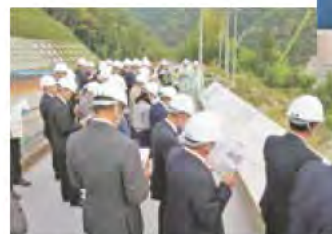
施工中の椋川ダムを熱心に視察しました
