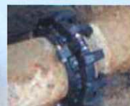
K形管路への取付(450mm)
