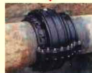
K形管路への取付(500mm)
