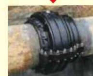
K形管路への取付(500mm)
